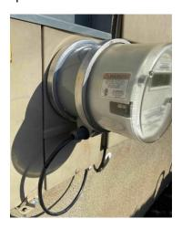
ConnectDER Solar Meter Socket Adapter
